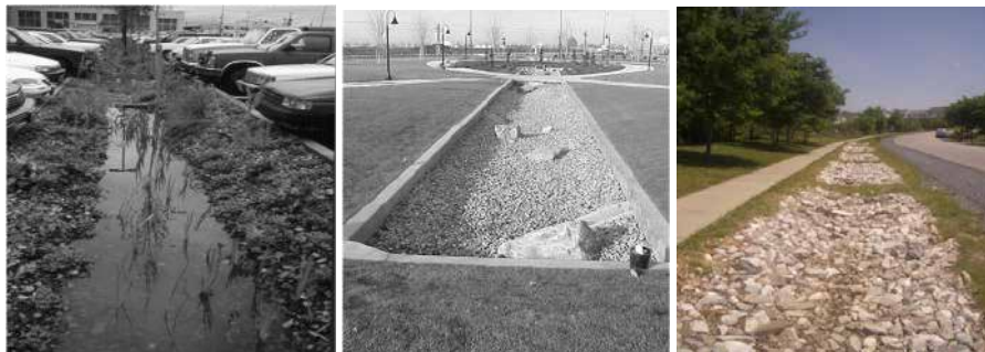
Figura 28 – Esempi di trincee d’infiltrazione
