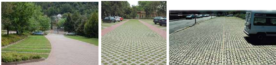
Figura 34 - Esempi di pavimentazioni permeabili
