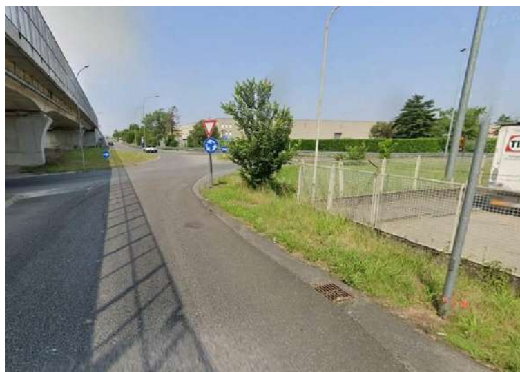
Figura 61 – Immagine della caditoia presente al piede della rampa di immissione nella SP14 in prossimità della rotatoria
