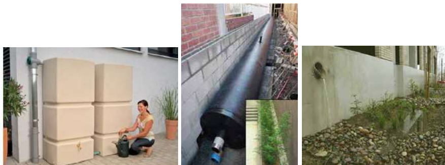
Figura 20 – Esempi di strutture di laminazione fuori terra delle acque dei tetti, strutturabili sia per la sola laminazione sia per il riuso
